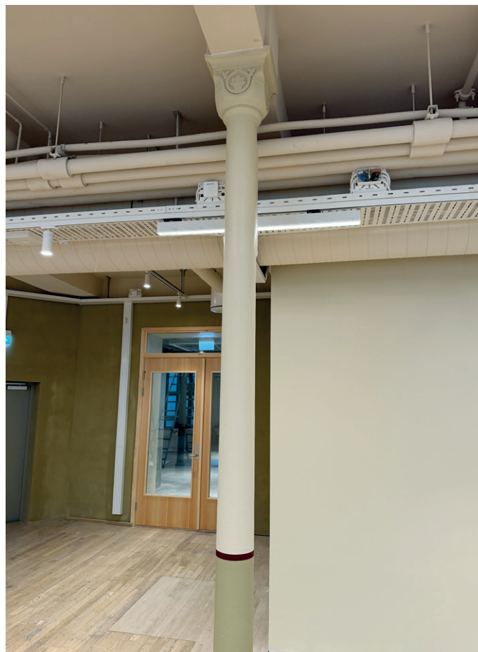
Vakkert utformede stålsøyler får skinn igjen i det rehabiliterte bygget.
