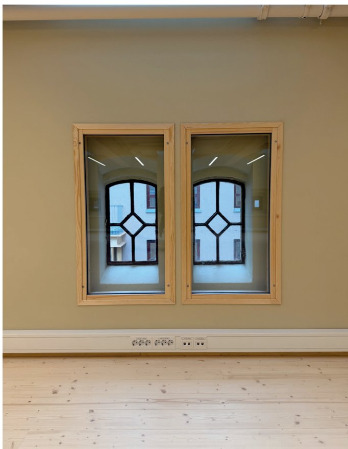
Gamle vinduer har latt seg gjenbruke blant annet ved å gi dem ekstra innglassing.
