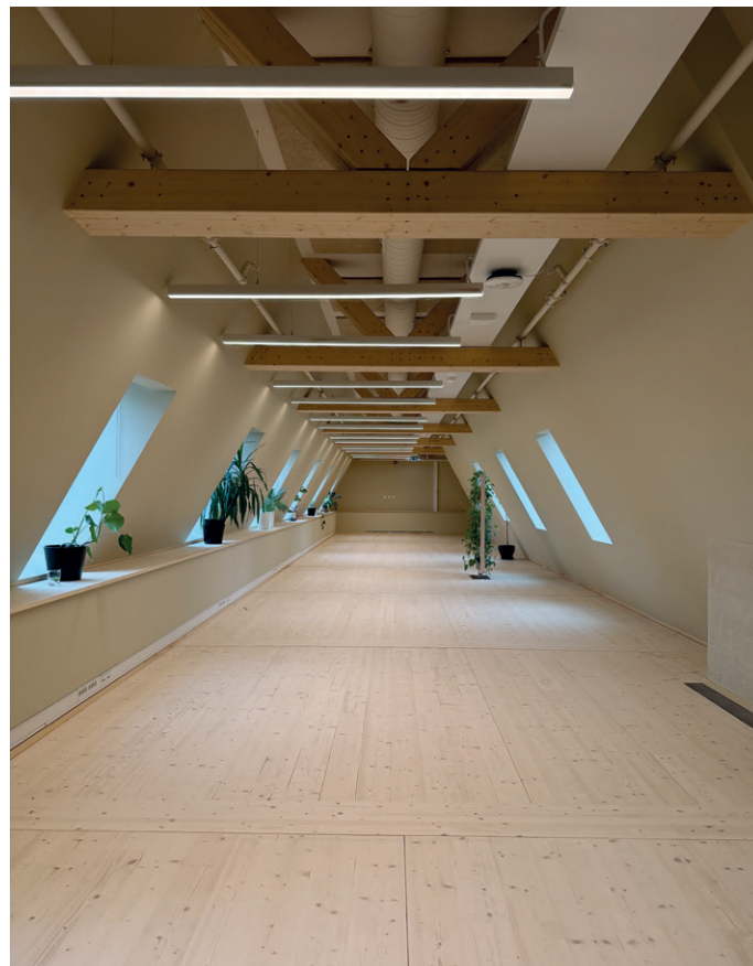
Et nytt, lettvektig tilbygg har gitt prosjektet to ekstra etasjer i toppen.
