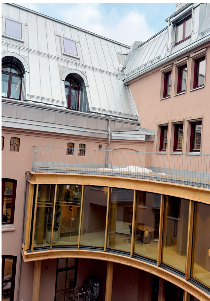
Inne i gårdsrommet har de gamle byggene fått et moderne løft med et nytt, buet tilbygg.
